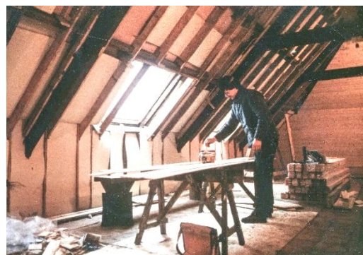
Vloerplaat van de zolder wordt gelegd, het dak wordt afgewerkt en men behandelt het houtwerk van de zolder.
