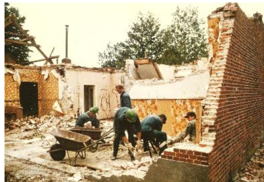
Sloop van de Kievit in 1987 waarbij u opmerkt dat de voorgevel van het gebouw al "gemoderniseerd" was met andere ramen en rolluiken.
