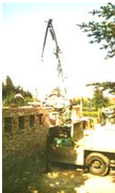
Vloerplaat van de zolder wordt gelegd, het dak wordt afgewerkt en men behandelt het houtwerk van de zolder.
