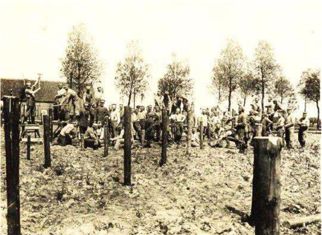
Op Ravels grondgebied gebruikt men voor "De Dodendraad" 1378 kg gladde ijzerdraad en 11 kg pindraad. Bovendien moet er een zone van 500 meter vrij zijn bij deze Bliksemende Draad.
