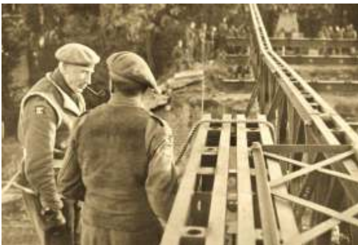
De Engelse generaal Barker bij de constructie van de Baileybrug in oktober 1944 te Ravels. Bron: HeE Nicolaus Poppelius
