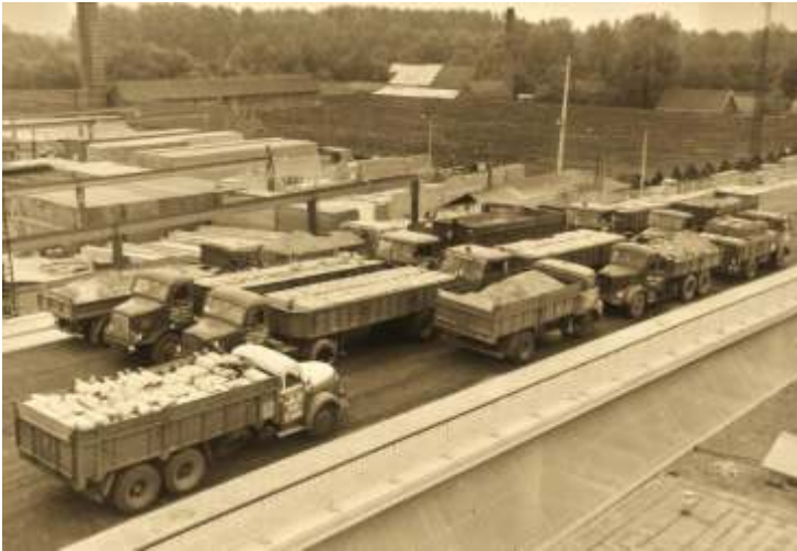
Testen van de “nieuwe betonnen brug” 1969, men bevindt zich hier aan de zijde van Turnhout. Bron: archief HeE Nicolaus Poppelius
