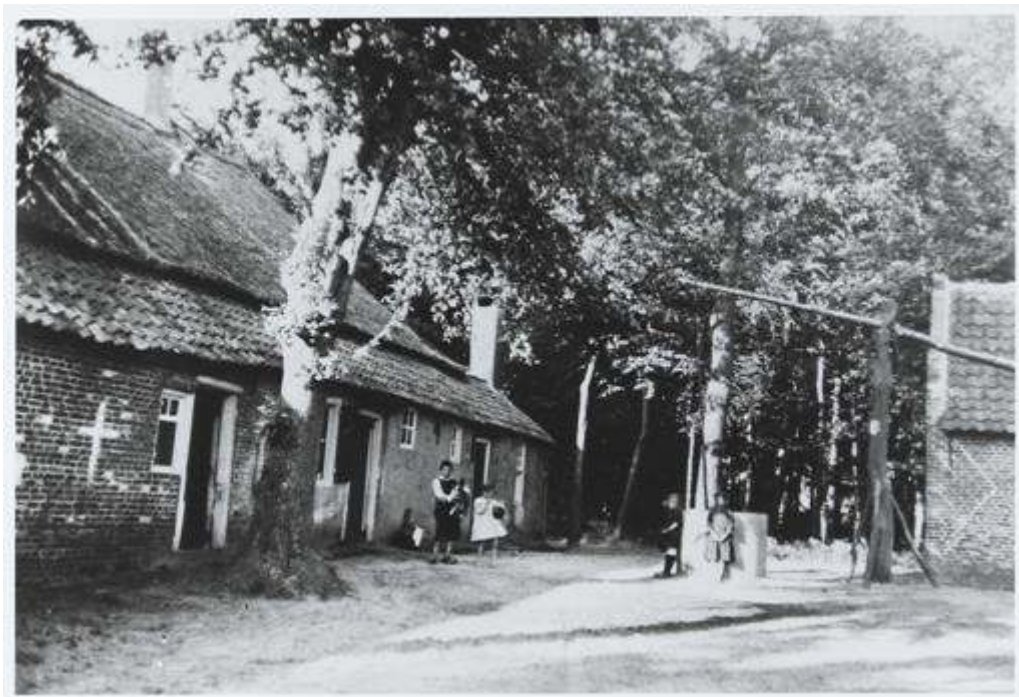
Herberg De Rook aan de Rooverstebaan, achterzijde. Foto uit het midden van de 20 e eeuw. Het kruis links op de buitenmuur is aangebracht om het onheil buiten te houden.
