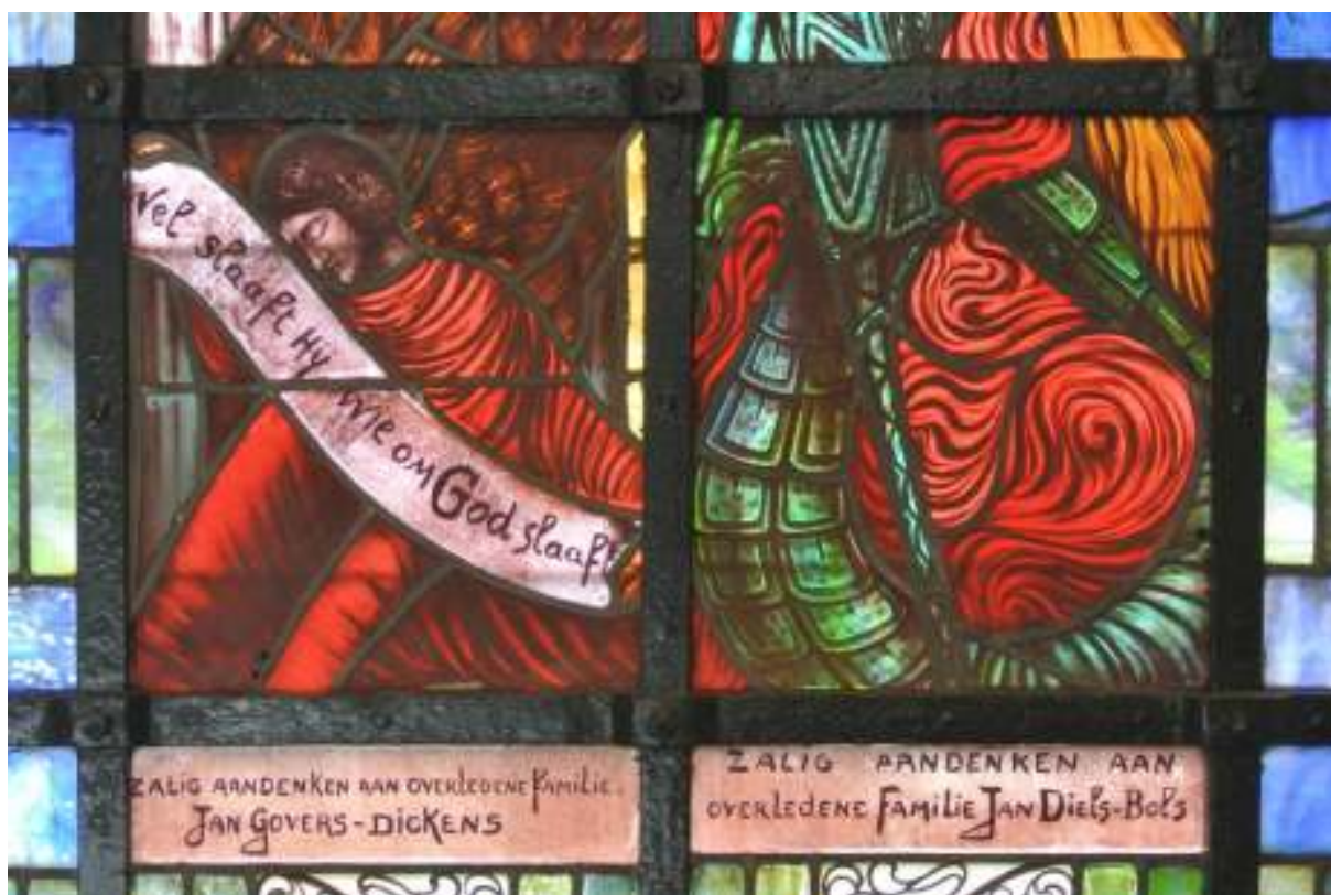
Techniek om het lood te wapenen met platte stalen staven
