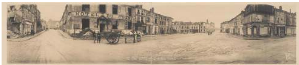
Saint-Mihiel, beschadigde woningen op de markt (bron 28/12/2018: Schutz Group Photographers Washington D.C.)
