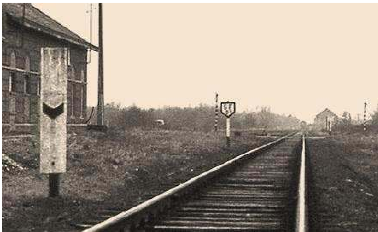
1974: links het stationsgebouw Weelde-Merksplas, in de verte zien we de contour van het grote grensstation Weelde-Staat/Baarle-Nassau-Grens met een diesellocomotief.
