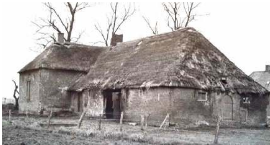
De Nieuwelandse Hoeve anno 1974 was erg verwaarloosd. Het is een van de oudste stenen gebouwen van Alphen (vergelijk met de andere foto's van deze hoeve in dit artikel)
